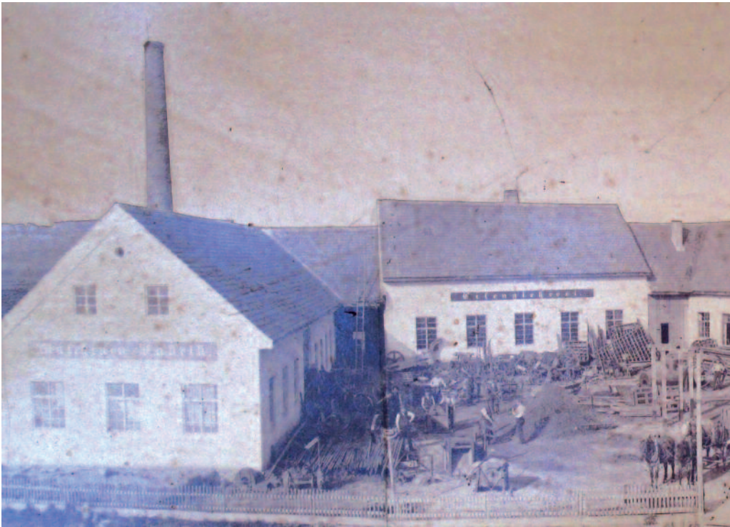
Die Anlage der Maschinenfabrik Stocker im Jahr 1886 mit Produkten aus eigener Fertigung. (Alois Stocker)
