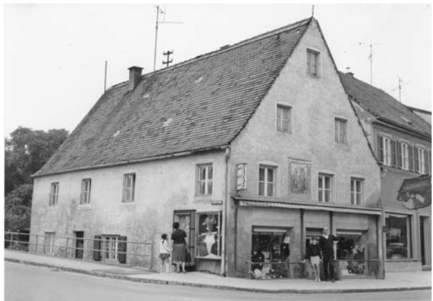
Das Modehaus Retzlaff nach dem Umzug in die Ingolstädter Straße [ca. 1960]
