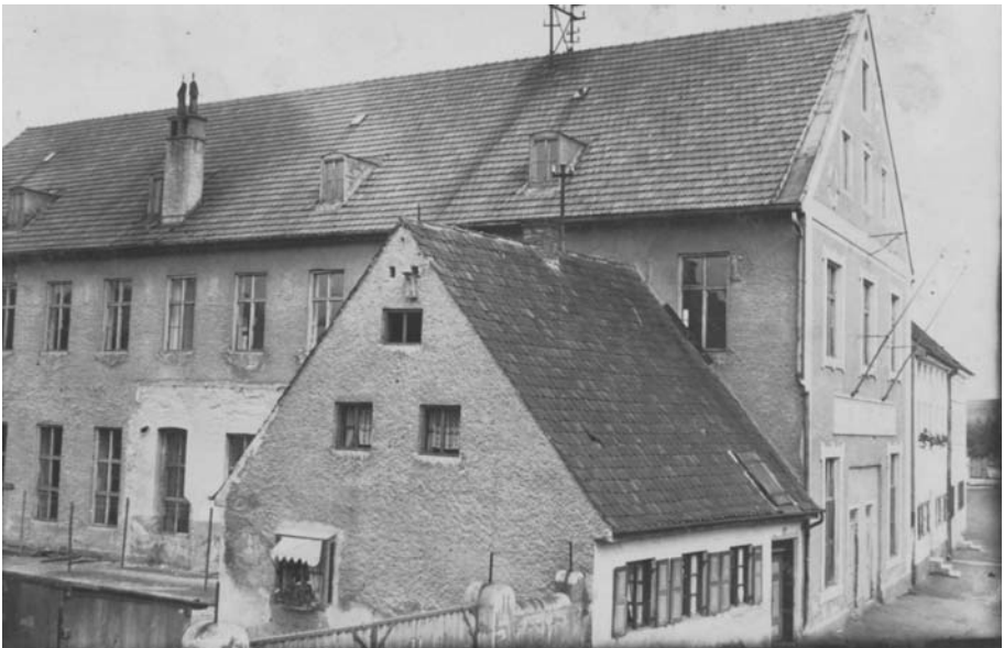
Die 1896 und 1900 zwischen Schwarzbach und Münchner Vormarkt errichteten Firmengebäude des Färbermeisters Ludwig König (ca. 1910).
