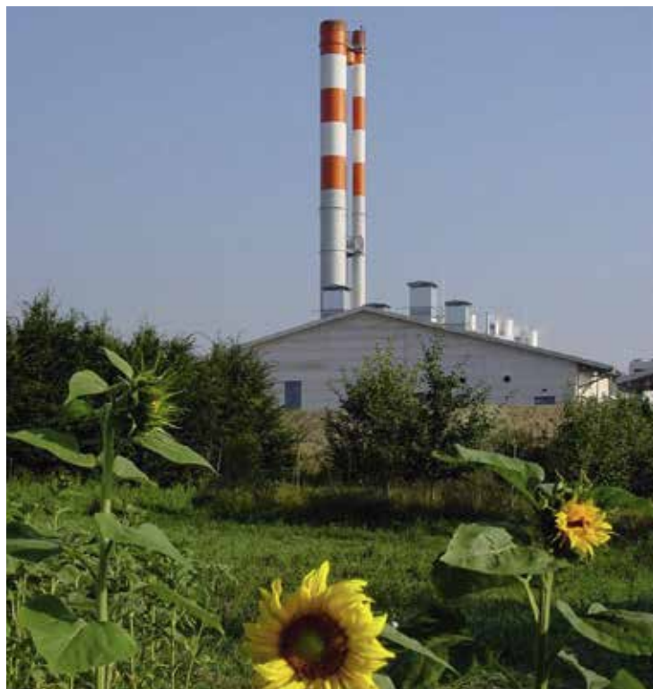
Das Biomasse-Heizkraftwerk erzeugt Wärme, Strom, Dampf und Kälte aus heimischen Holzhackschnitzeln.
