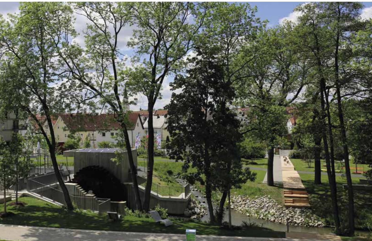
Die Arlmühle liefert sauberen Strom aus Wasserkraft. Das große Holzrad von sechs Metern Durchmesser erzeugt ca. 75.000 Kilowattstunden Strom im Jahr, genug für 20-30 durchschnittliche Haushalte.
