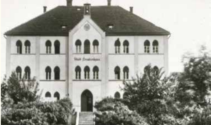
Das Krankenhaus im Jahr 1892 nach der Aufstockung
