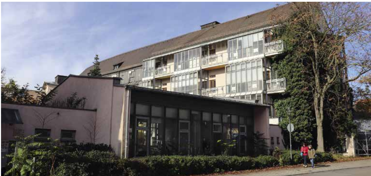
Türltorstraße: Auch der Mehrzwecksaal des ehemaligen Pflegeheims St. Franziskus wird abgerissen.
