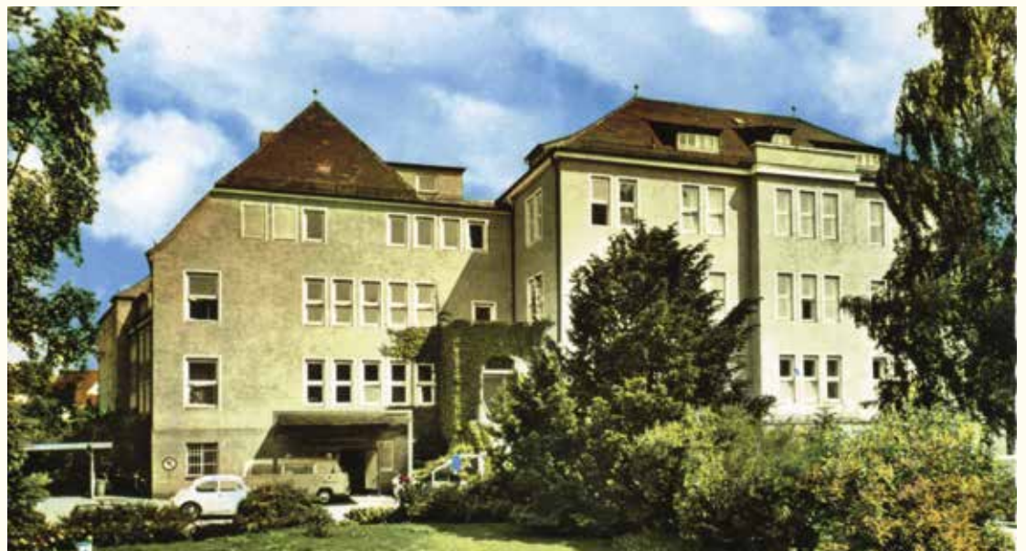
Ansicht mit Rückgebäude und Anlieferungsbereich für Patienten (ca. 1960)
