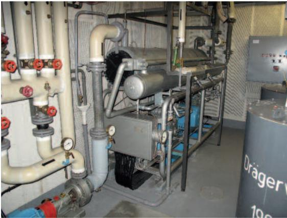
Mit einem aufwendigen Leitungssystem wurden im Belüftungs- und Kühlraum (Raum 24) die Luftverhältnisse in der gesamten unterirdischen Fernmeldeanlage gesteuert und überwacht [2014].
