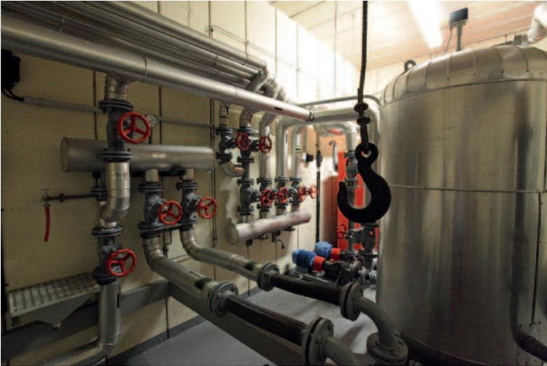
Aus den Leitungen, die von den beiden unterirdischen Brunnen nach oben führten, wurde das für unterschiedlichsten Bedarf benötigte Wasser hochgepumpt. Der mit einer Tragfähigkeit von über vier Tonnen ausgestattete Haken diente dem Heben der Brunnenanlage für Wartungsarbeiten.
