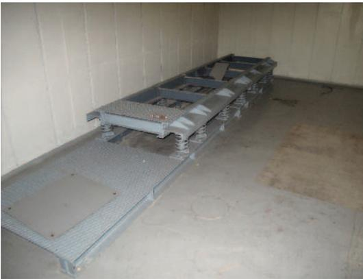
Im Batterieraum (Raum 05) waren zwei Trockenbatterien untergebracht, die als letzte Sicherheit der Energieversorgung dienten, sollte die Versorgung durch die Amperwerke ausfallen und das Notstromaggregat ebenfalls nicht funktionieren. Die Batterien ruhten auf einem federgedämpften Gestell, um Detonationen abzuschwächen [2014].
