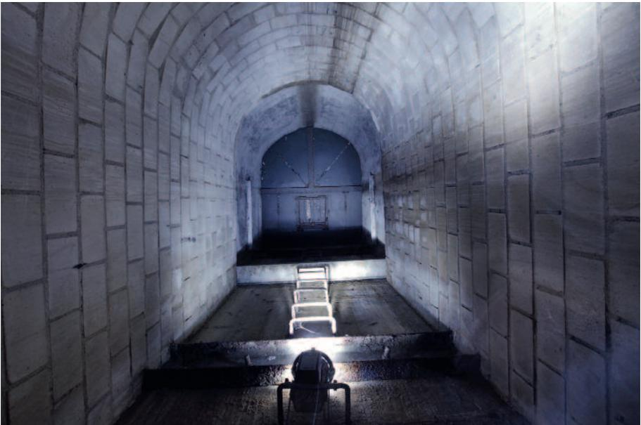
Einer der beiden Notausstiege aus dem Bunker diente auch als Transportschacht für größere Geräte oder Teile, die bei den Maschinen bedarfsweise ausgewechselt werden mussten. Die mit Sandsäcken und Kies gefüllten Notausstiege mussten jedoch grundsätzlich verschlossen bleiben, um potentielle Eindringlinge vom Inneren des Bunkers abzuhalten. Nur im Notfall hätte die Füllung entfernt werden dürfen, um ins Freie zu gelangen.
