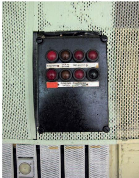
Sowohl im Fernsprech- als auch im Fernschreibraum, deren Türen bei Dienstbetrieb stets verschlossen sein mussten, war ein Warnsystem installiert. Es sollte die Mitarbeiter rechtzeitig über den Ausfall der Energieversorgung oder des Kühl- und Belüftungssystems informieren [2014].
