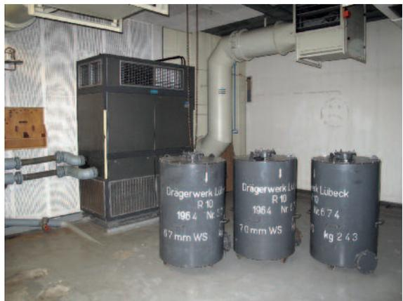
Für die Funktion des Motors waren Kohlenfilter der Firma Drägerwerk eingebaut. Im Hintergrund sind die Regelungswerke für das Notstromaggregat zu sehen (2014).
