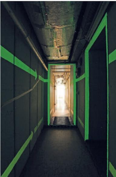
Lumineszierende Elemente waren zur Sicherheit des Personals an allen Fluren und Durchgängen angebracht. Bei Notstrombetrieb oder bei völliger Dunkelheit waren eine Orientierung und ein schnelles Fortbewegen in den Gängen möglich.
