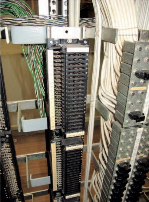
Technische Einheit für die Schaltverteilung und die Verbindung zur Haupteinheit (Mitte) sowie auf der rechten Seite die Durchschalteinheiten. Die Kabel und Schaltrelais wurden größtenteils entfernt [2014].
