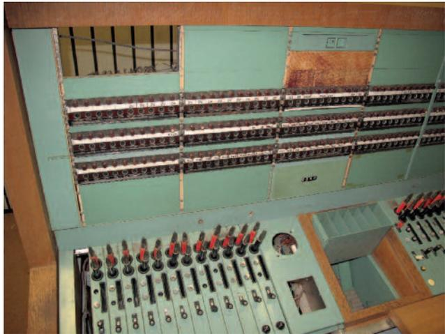
Detail eines Arbeitsplatzes der Fernsprechvermittlung, deren Technik größtenteils ausgebaut wurde. Bei einem eingehenden Anruf wurde mit dem roten Stecker die Verbindung angenommen und nach Abfragen des gewünschten Kontakts mit dem schwarzen Stecker die Verbindung hergestellt (2014).
