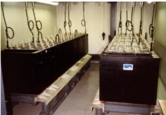
Von beeindruckender Größe waren die beiden Trockenbatterien in der Fernmeldeanlage, die als letzte Sicherung der Stromversorgung dienten (Aufnahme aus der GSVBw21).
