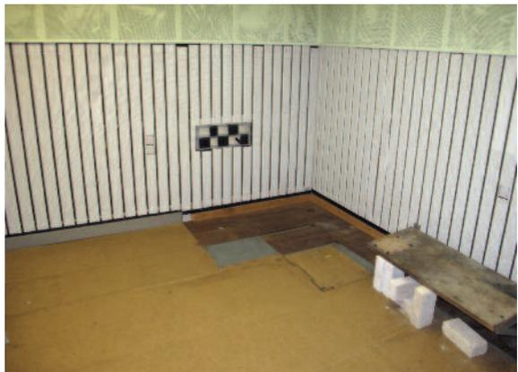
Wandverkleidung mit schalldämpfenden Elementen im Fernschreiberraum (Raum 10) zur Reduzierung der Geräusche der Fernschreibmaschinen. Auch hier befand sich eine erschütterungshemmende Bodenkonstruktion, um die technische Ausstattung zu schonen (2014).
