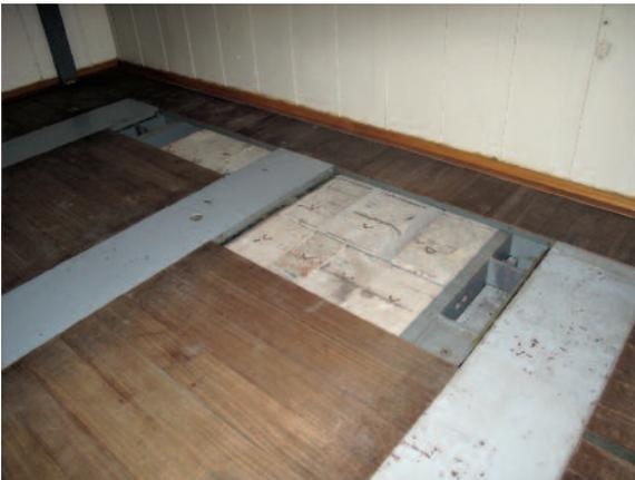
Der Verteilerraum (Raum 02) war einer derjenigen Räume, die aufwendige Technik beherbergten. Um Erschütterungen der Geräte abfedern zu können, war er mit einem schwimmenden Boden ausgestattet. Abgedeckt war er mit Teakholz (2014).
