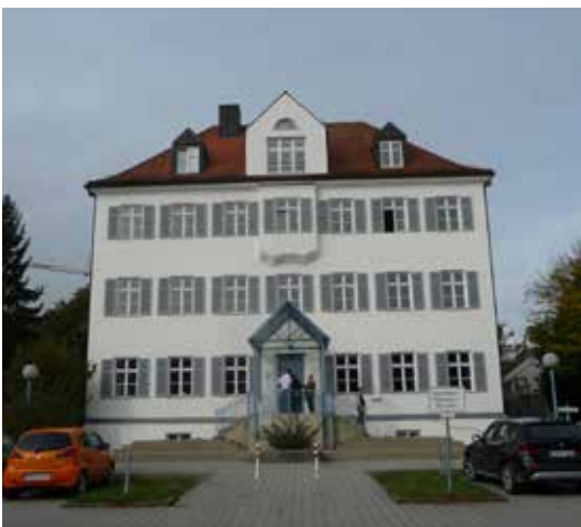
Abb. Amtsgericht Ingolstädter Straße 45
