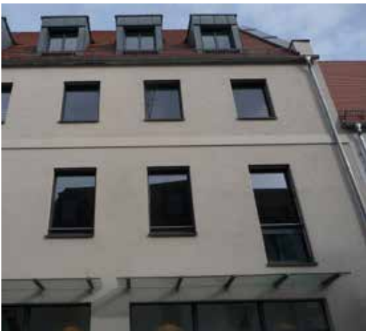
Abb. einfache Fassadengestaltung in Obergeschossen
