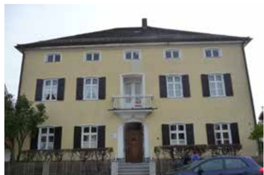
Abb. freistehendes gründerzeitliches Stadthaus, Ingolstädter Straße 42
