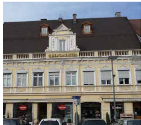
Abb. Schmuckfassade mit aufwendigen Faschen und Zwerchgiebel am Gebäude Hauptplatz 16
