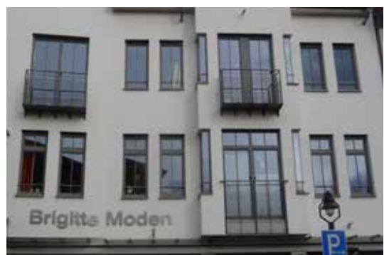
Abb. neue Bebauung mit Erkerbildung und geteilten, hochformatigen Fenstern in der Türlltorstraße
