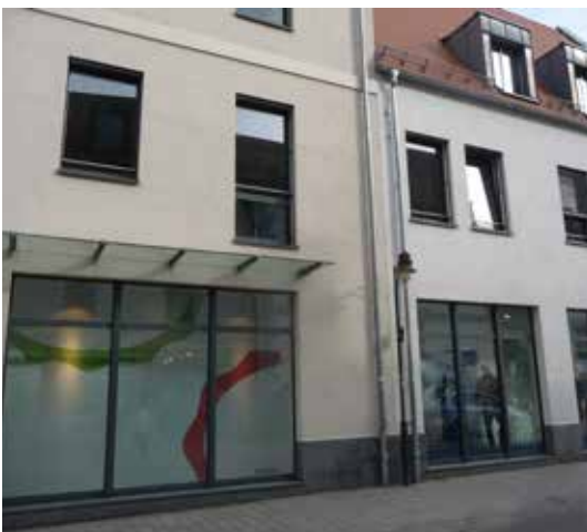
Abb. Ablesbarkeit der ehemaligen Parzellierung bei durchgängiger Ladenfläche Hauptplatz / Ingolstädter Straße
