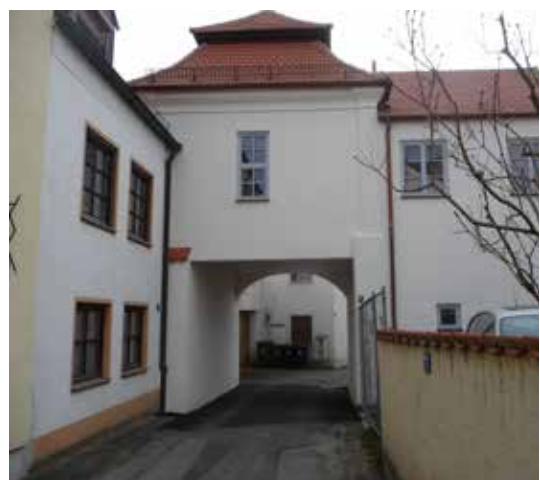
Abb. gut sanierter Flaschlturm
