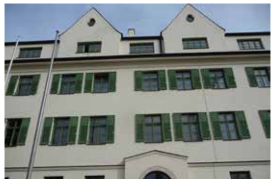
Abb. Fassade des Vermessungsamtes Kellerstraße 6
