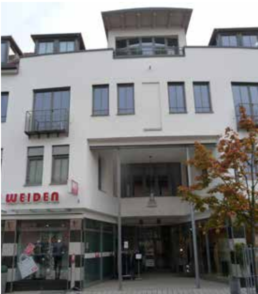
Abb. moderne repräsentative Geschäftsbebauung in der Türlltorstraße
