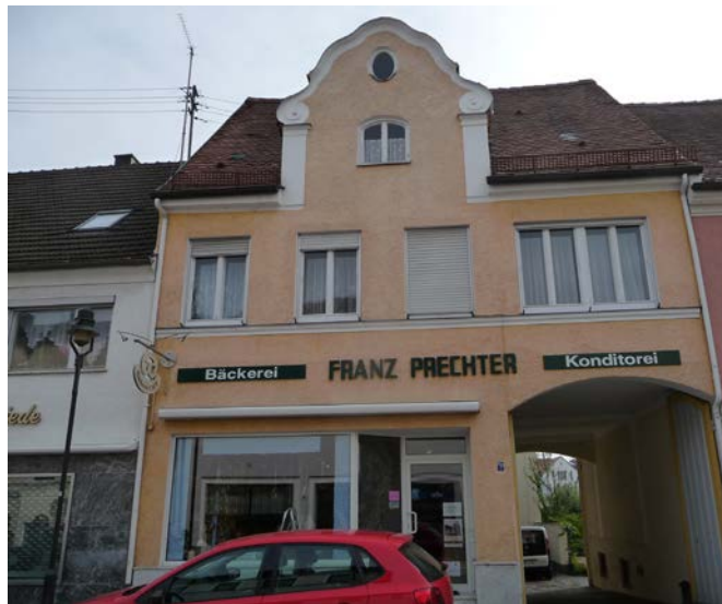
Abb. Haus mit Tordurchfahrt, Ingolstädter Straße 22
