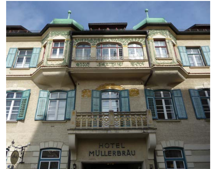
Abb. erhaltenswerte Erkergestaltung, Verzierung und Fensterläden am Gebäude Hauptplatz Nr. 2
