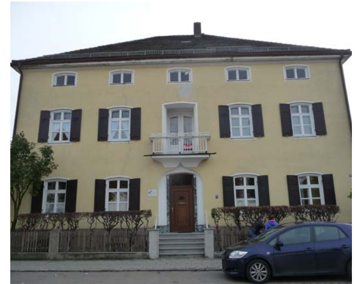
Abb. freistehendes gründerzeitliches Stadthaus, Ingolstädter Straße Nr. 42
