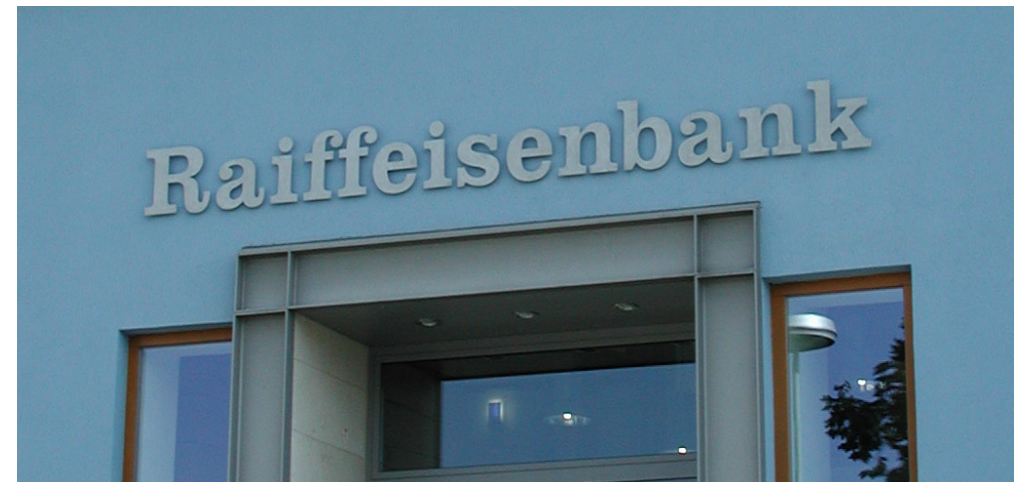
Abb. Beispiel für Werbeanlage mit Einzelbuchstaben, Raiffeisenbank Parsberg
