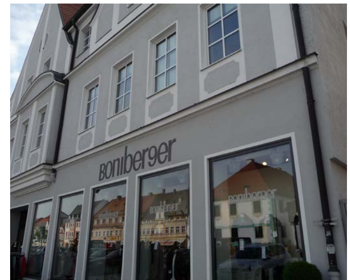
Abb. fassadenverträglicher Werbeschriftzug, Hauptplatz Nr. 35
