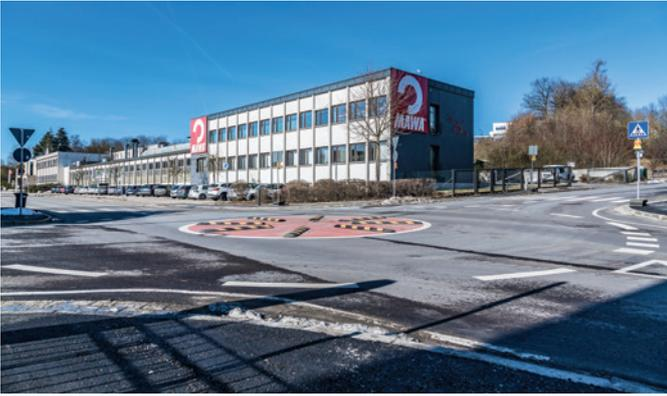
Ein Minikreisverkehr wurde gebaut und drei Zebrastreifen angebracht. Um ein „Drüberrauschen“ zu verhindern, soll die Kreiselmittle noch erhöht und mit Reflektoren an der Aufkantung versehen werden. Die provisorischen Schwellen werden wieder entfernt. Zusätzlich wird vor dem Kreisel Tempo 30 aus allen Richtungen gelten. Ein Schutzstreifen für Radfahrer soll stadtauswärts vom Kreisel bis zur Anton-Schranz-Straße führen.
