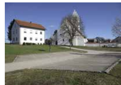
Mitten im Dorf, direkt neben der Kirche, wird die Kita in Affalterbach gebaut.
