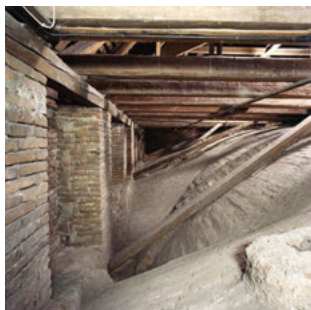
Die Spitalkirche hat als einziges Gebäude aus der Ära der Franziskaner in Pfaffenhofen überlebt. Seit 2015 läuft mit Unterbrechungen eine umfassende Sanierung des nunmehr 300 Jahre alten Sakralbaus (2015). (Elisabet Dönlbacher)
