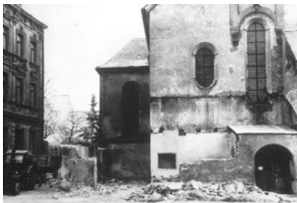
Im Zuge der Arbeiten am Arkadengang für das Ehrenmal im Jahr 1950 wurden die nach 1800 angebrachten Anbauten an der Kirche beseitigt, womit ein Blick auf die Südfassade möglich war. [Staatsarchiv Pfaffenhofen a. d. Inn]
