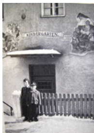
Der im ehemaligen Franziskanerklostergebäude untergebrachte, 1871 gegründete städtische Kindergarten erfuhr 1930 eine Renovierung und Neugestaltung der Eingangsseite (um 1930) (Jahresheft des Vereins des Ortsvereins Pfaffenhofen, 1935, S. 46ff)
