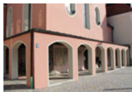
Der Arkadengang im Jahr 2013, der einer Sanierung unterzogen wird (Elisabeth Seiwald)
