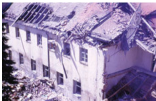
Im Mai 1969 liefen die Abrucharbeiten am Spital, dem alten Konventgebäude, auf vollen Touren. (Johann Foidel)
