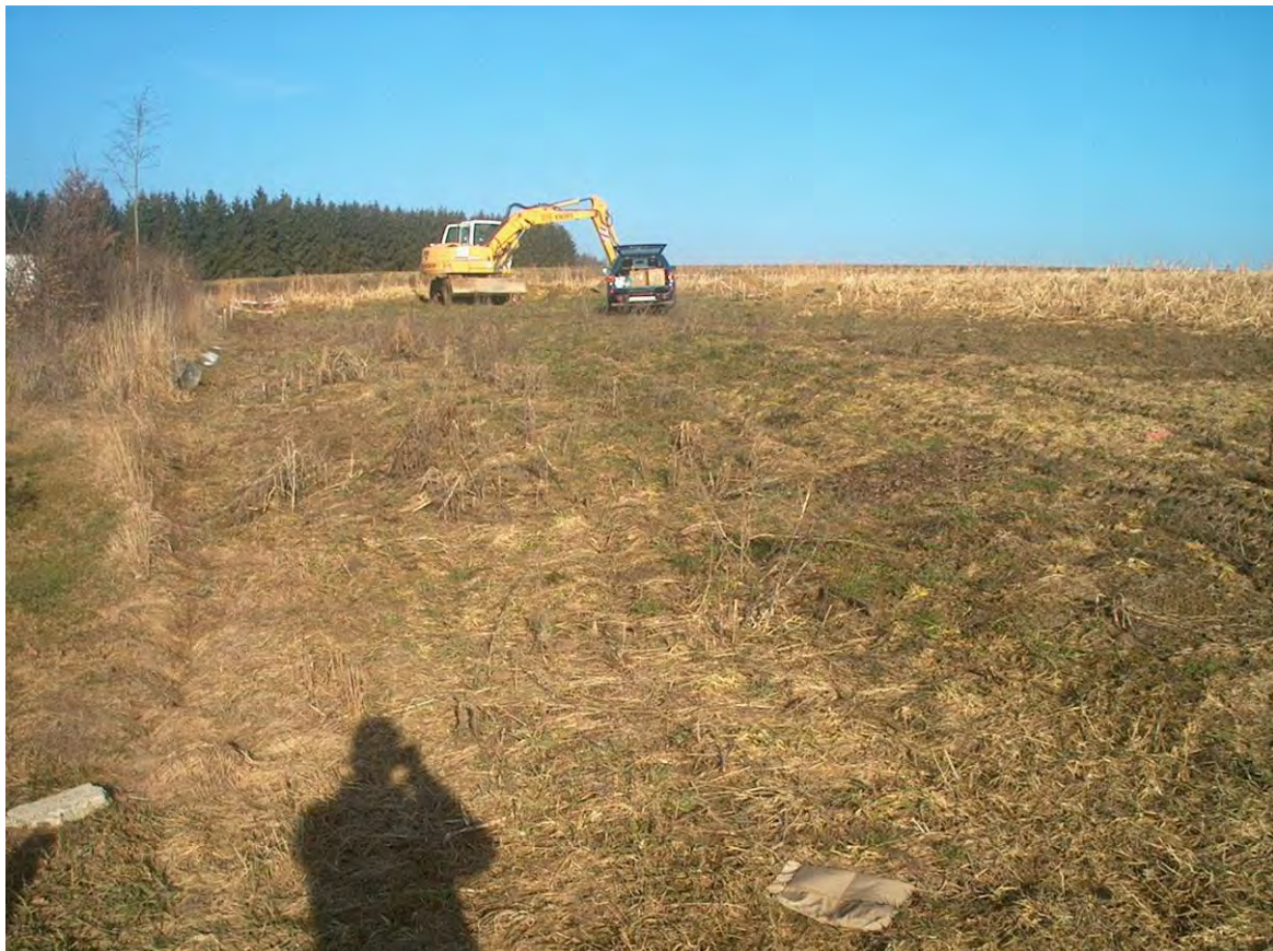
Bild 2: Ansicht Baufeld (Blickrichtung nach Nordwesten)
