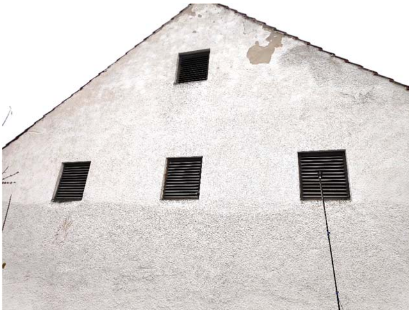
Abbildung 8 Lüftungsöffnungen an der Nordfassade
