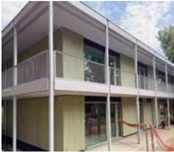
Die Kita St. Elisabeth wird momentan gebaut.
