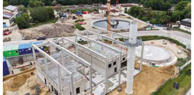
Die Bauarbeiten an der Pfaffenhofener Kläranlage schreiten weiter voran.
