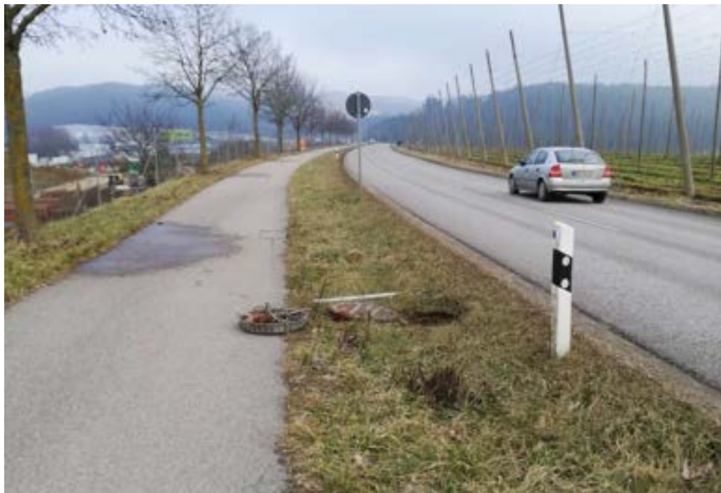
Abbildung 5-4: Mulde 2 mit Überlaufschacht zur Mulde 1, Blick nach Norden, 2024
