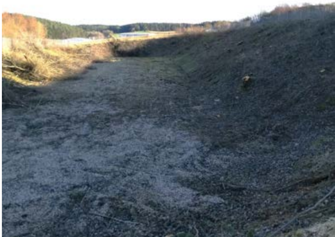
Abbildung 3-19: Foto Becken B nach Rodung der Böschung
