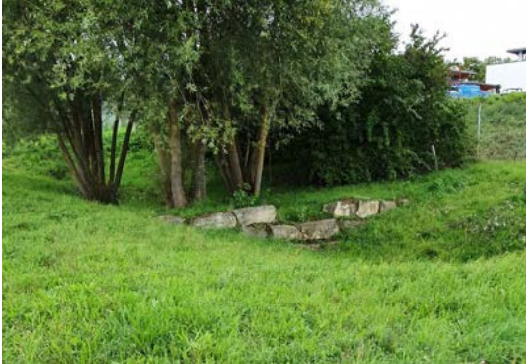
Abbildung 3-9: Kaskaden-Überlauf der Versickerungsmulde M1
