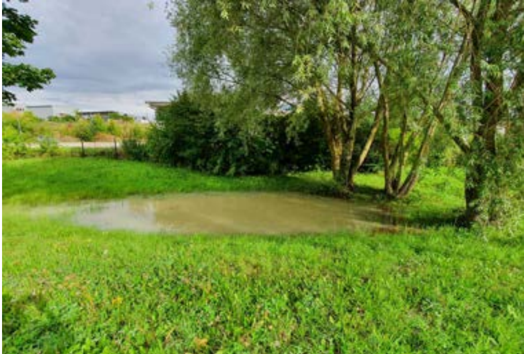
Abbildung 3-10: permanent eingestautes Becken der Versickerungsmulde M1
