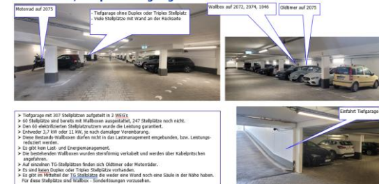
Erste Bestandsaufnahme Infrastruktur; Stellplätze Tiefgarage
