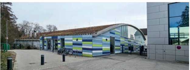
N2 Turnhalle der Grund- und Mittelschule, Niederscheyerer Straße 19
