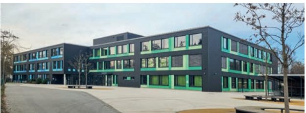
N1 Grund- und Mittelschule, Kapellenweg 14
