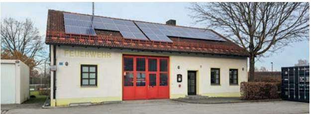
L8 Feuerwehr Uttenhofen, Bahnstraße 14
