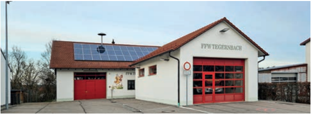
L7 Feuerwehr Tegernbach, Göbelsbacher Straße 6
