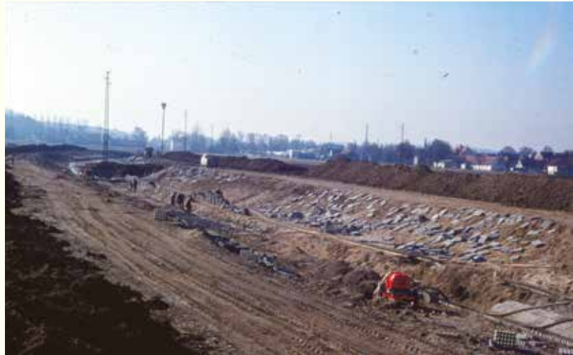
Entlang der Ilm erfolgten ab den 1970er Jahren Maßnahmen zur Hochwasserfreilegung.
