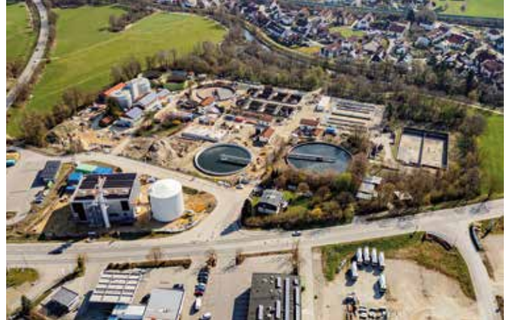
Die Arbeiten an der Kläranlage an der Joseph-Fraunhofer-Straße gehen voran.
