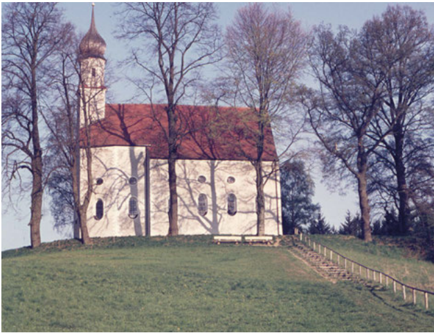
Der Treppenaufgang zur Kirche (1975)
