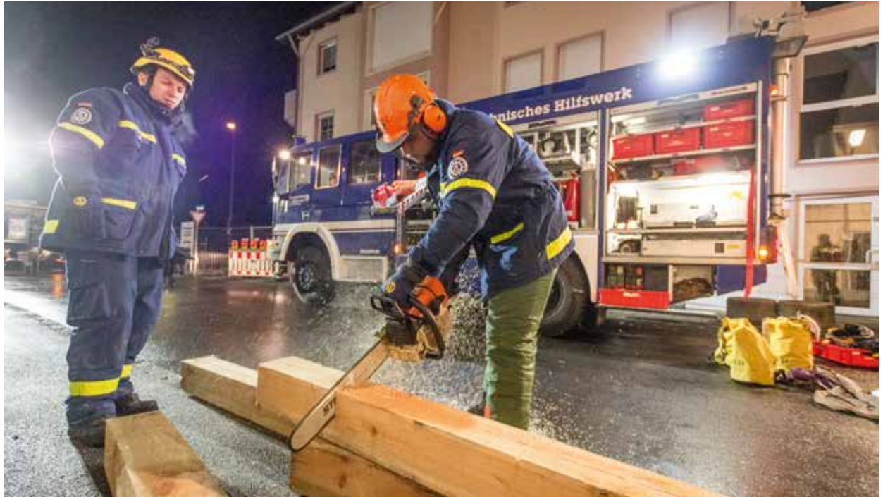
THW-Einsatz in Manching im November 2016: Nach dem Brand eines Wohnhauses waren aufwändige Arbeiten zur Sicherung des Gebäudes notwendig.
