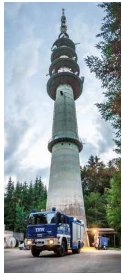
Stromeinspeisung durch das THW Pfaffenhofen am Funkturm in Wolfsberg
